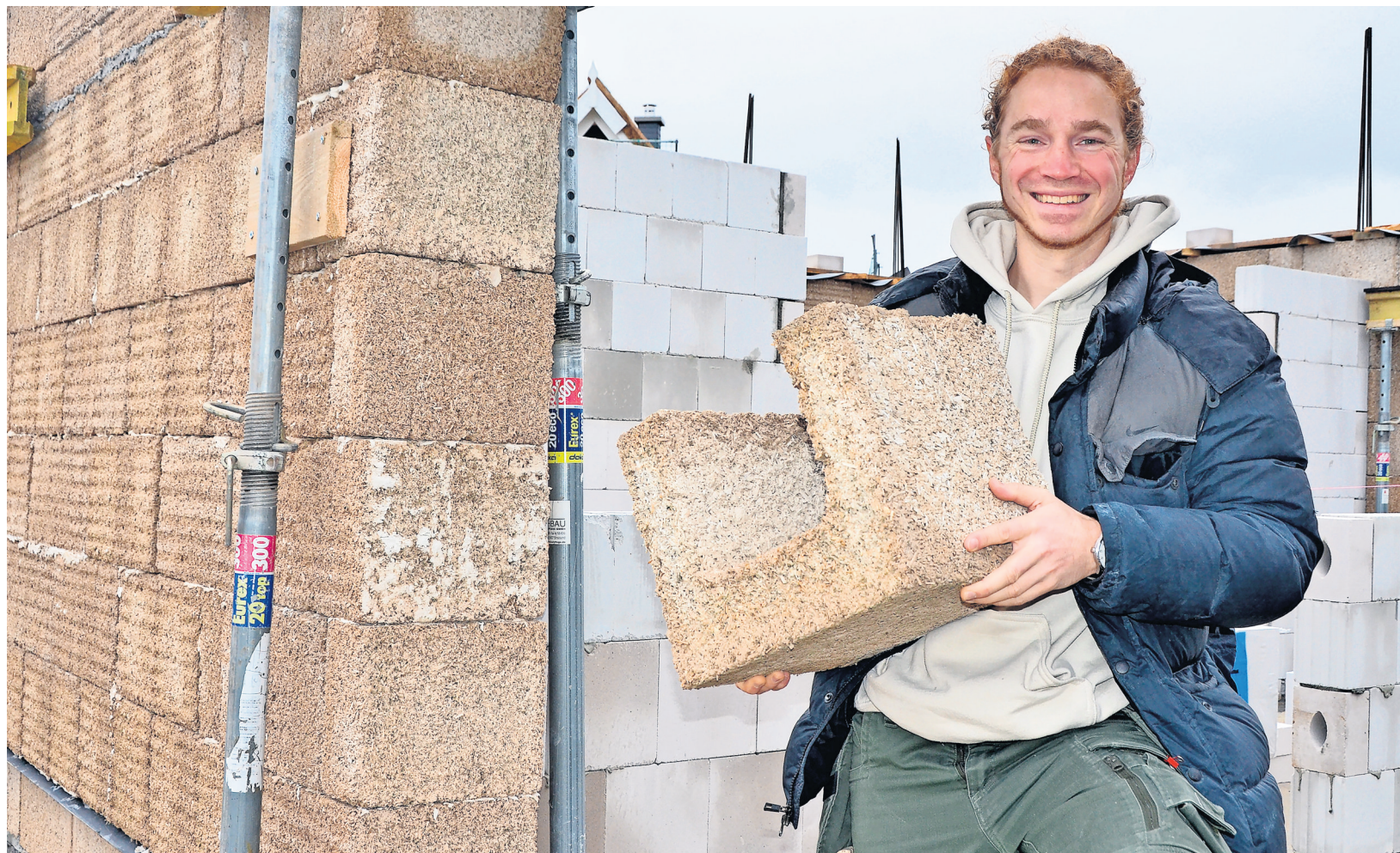
Henrik Pauly ist Deutschlands erster Hanfingenieur. Er setzt auf nachhaltiges Bauen und schwärmt vom Baustoff Hanf. In Puddemin entsteht ein Haus, das fast ausschließlich aus Hanf besteht.
